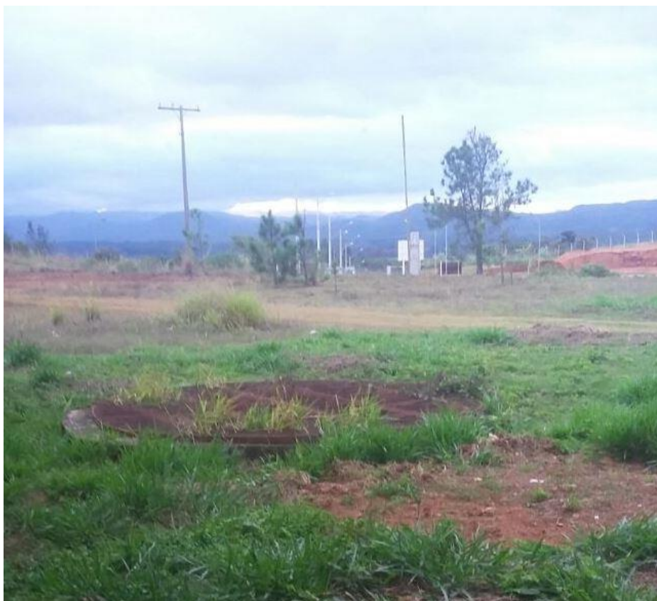
Figura 10: Reservatório de captação de água pluvial
