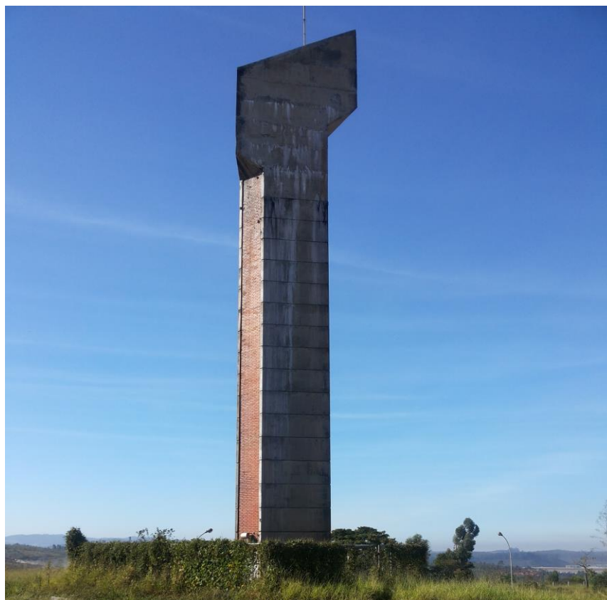
Figura 7: Ponto de entrada de água
