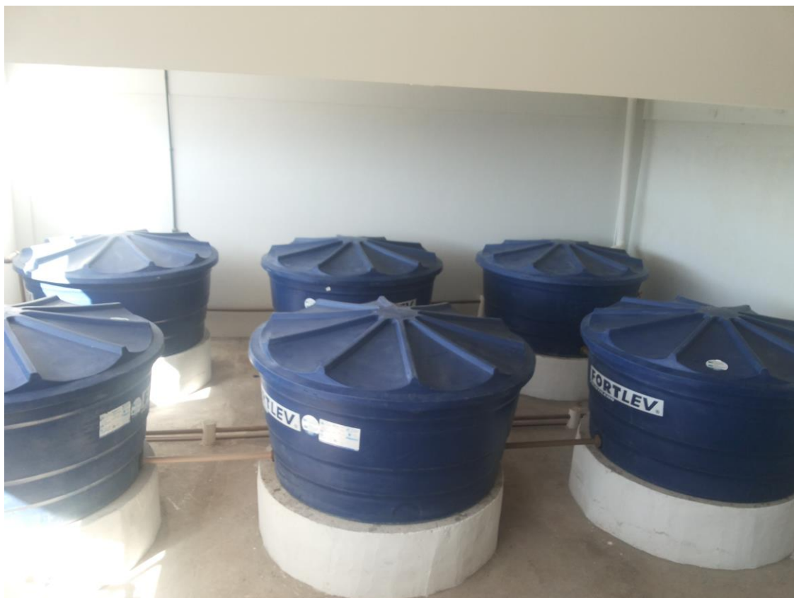
Figura 11: Disposição das caixas d'água da biblioteca
