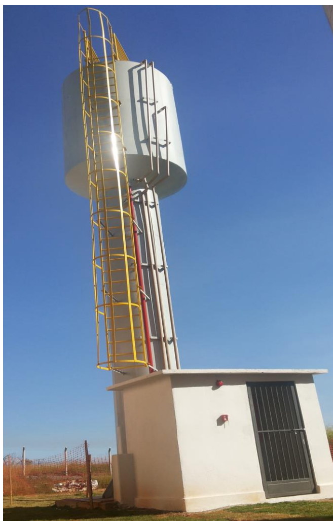
Figura 9: Reservatório dos laboratórios
